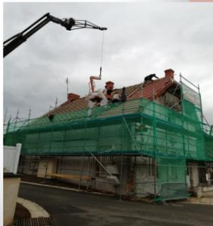
Les travaux de réhabilitation du bâtiment de la Poste ont démarré début 2023, par des travaux de façades, de chauffage et de toiture.
