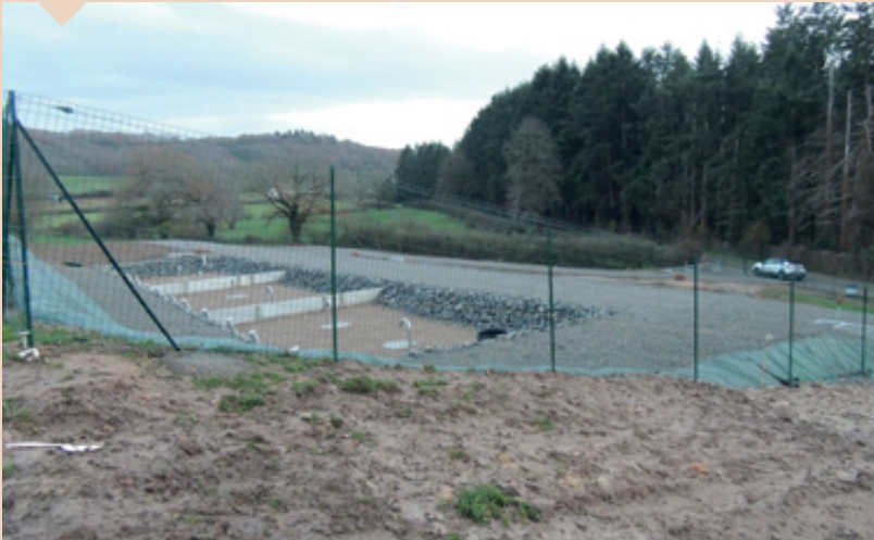
// TRAVAUX STATION D'ÉPURATION DU RINCEY
