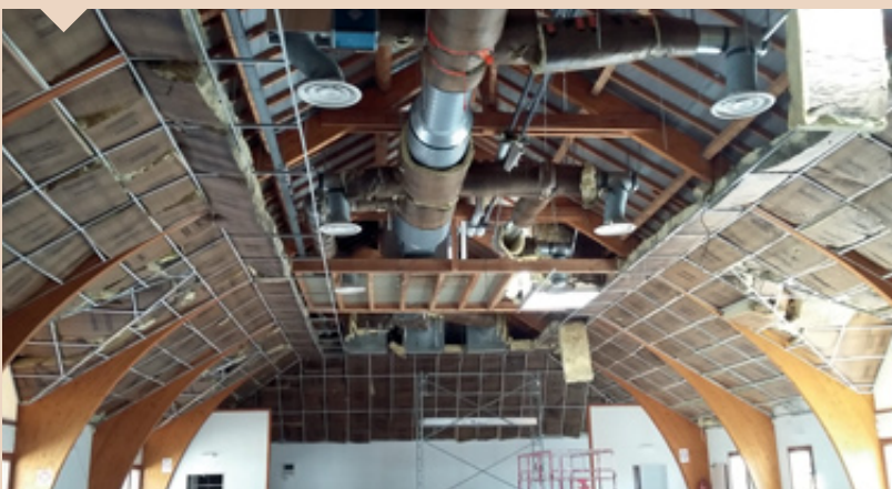
// TRAVAUX SALLE DES FÊTES
