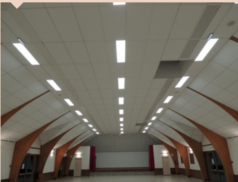
// SALLE DES FÊTES APRÈS TRAVAUX
